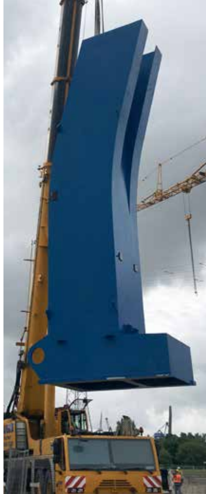
Die Pylone werden eingesetzt
