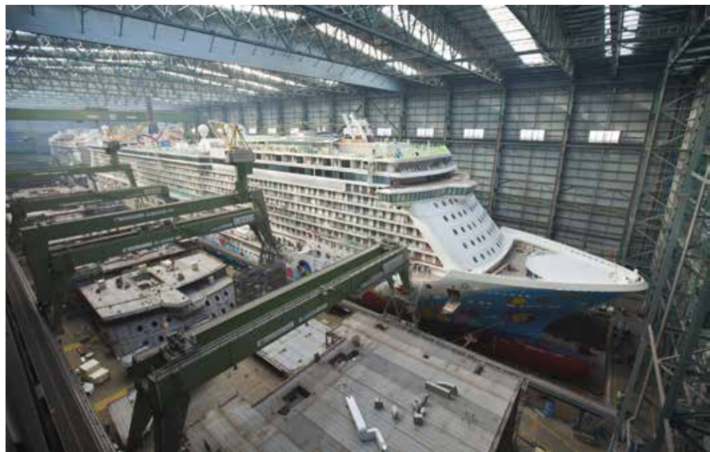
In den vergangenen Jahrzehnten hat sich die Meyer Werft durch den Bau großer und anspruchsvoller Kreuzfahrtschiffe weltweit einen exzellenten Ruf erworben. Immer wieder beeindruckend die riesige Werfthalle. (Foto: Meyer Werft)
