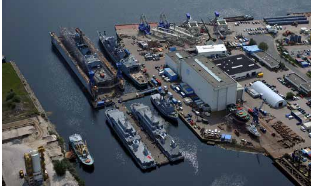
Im Jahr 2004 übernahm die Lürssen-Gruppe die Neue Jadewerft in Wilhelmshaven, die auf Wartung, Reparatur und Modernisierung von Einheiten bis 150 m Länge spezialisiert ist. Die Jadewerft gilt auch als eines der führenden Unternehmen bei der Instandhaltung großer Marineschiffe. (Foto: Lürssen)
